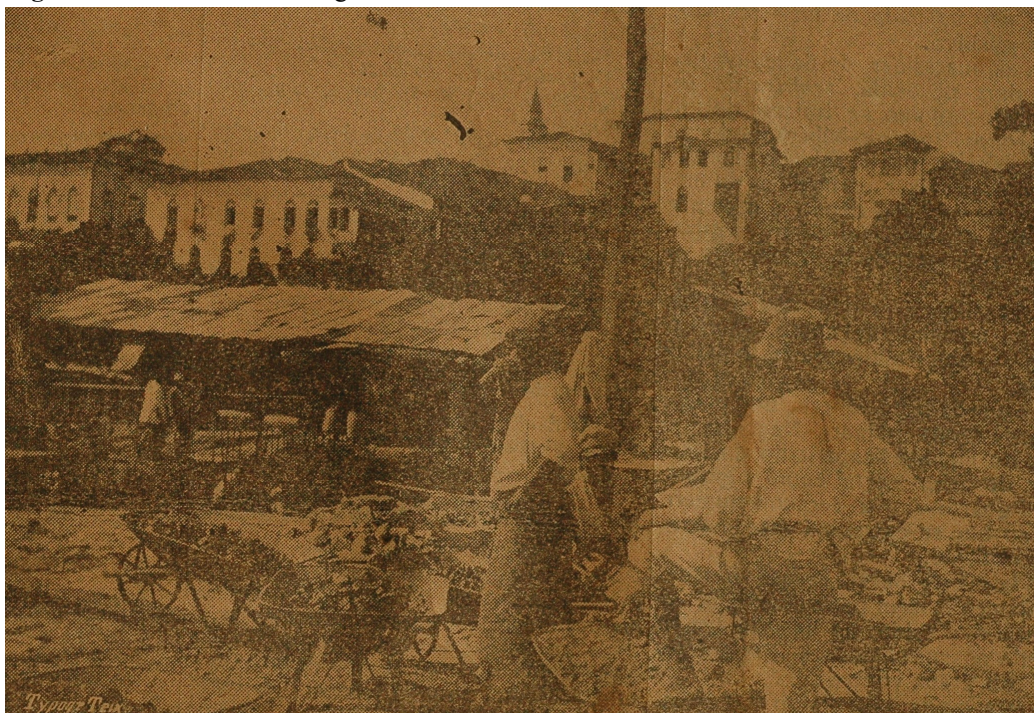
Figura 25 – Obras da Ulen: esgotos no Cais da Palmeira
