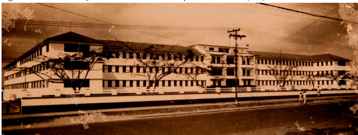
Figura 52 – Fachada do Quartel do 24º Batalhão de Caçadores – São Luís (MA)
