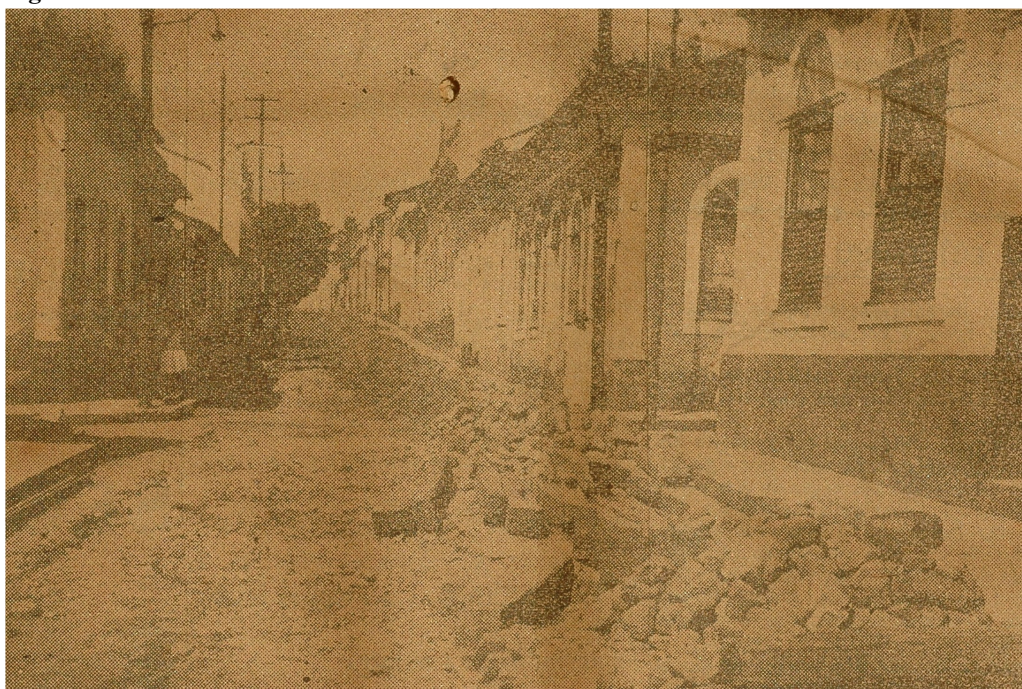
Figura 26 – Obras da Ulen na Rua Coronel Collares Moreira
