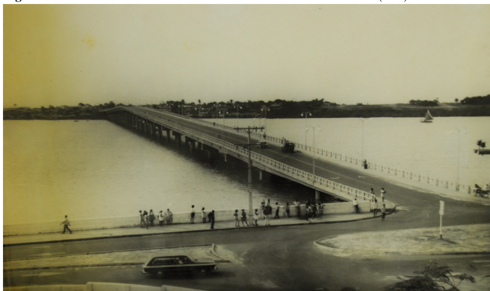
Figura 74 – Avenida Beira-Mar e Ponte do São Francisco - São Luís (MA)
