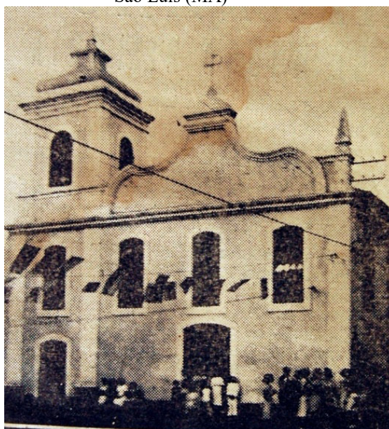
Figura 56 - Igreja de Nossa Senhora da Conceição - São Luís (MA)
