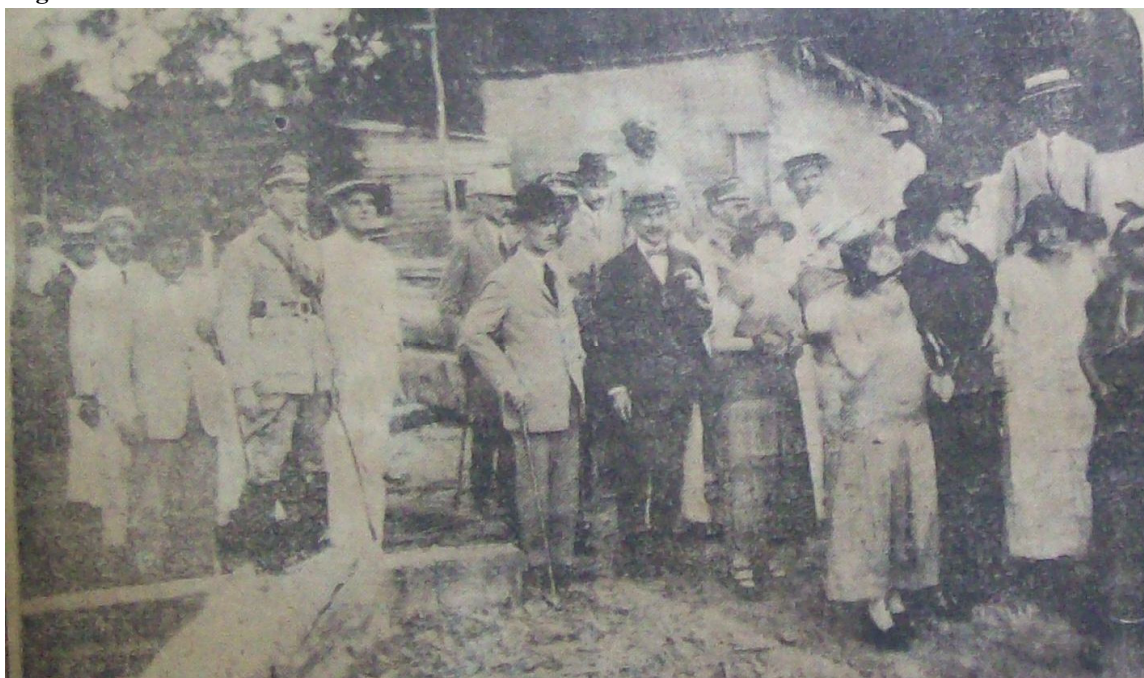
Figura 22 – Godofredo Viana em visita às obras da Ulen
