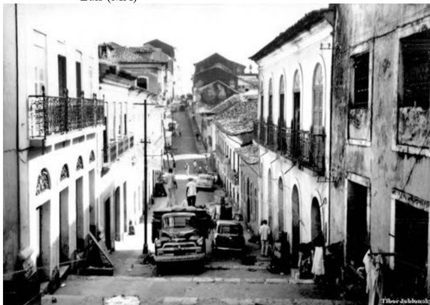
Figura 61 – Escadaria da Rua Vinte e Oito de Julho (Rua do Giz) - São Luís (MA)
