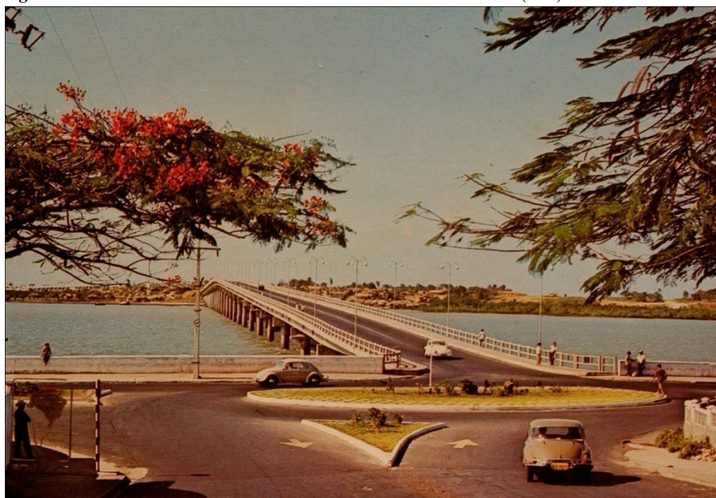
Figura 71 – Avenida Beira-Mar e Ponte do São Francisco - São Luís (MA)
