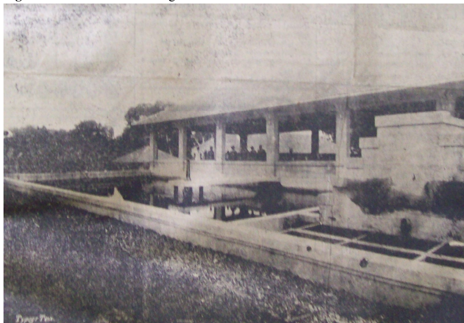
Figura 24 - Reservatório d’ água no Sacavém
