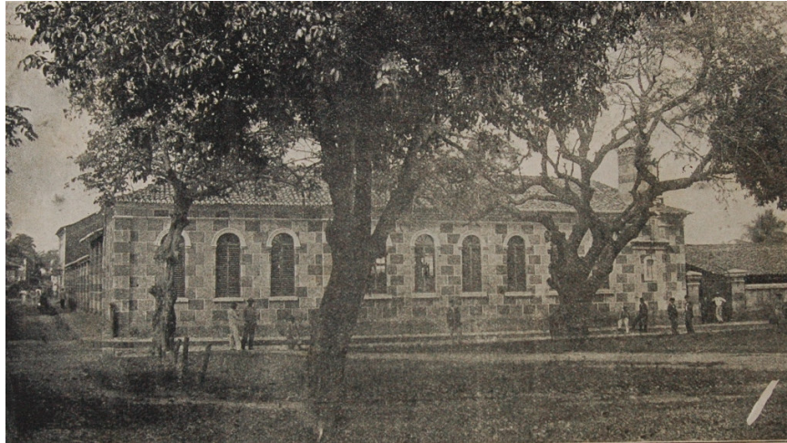
Figura 13 - Companhia de Iluminação a Gaz do Maranhão – São Luís (MA)
