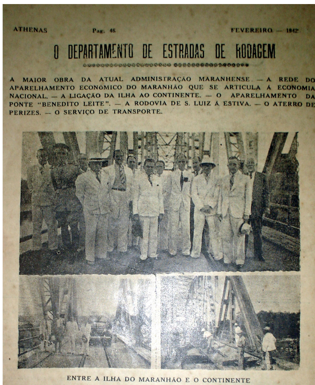
Figura 40 – Aparelhamento da Ponte Benedito Leite – entre São Luís e o continente
