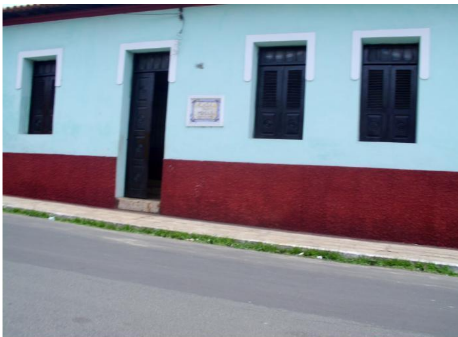
Imagem 7 – Fachada da Casa das Minas
