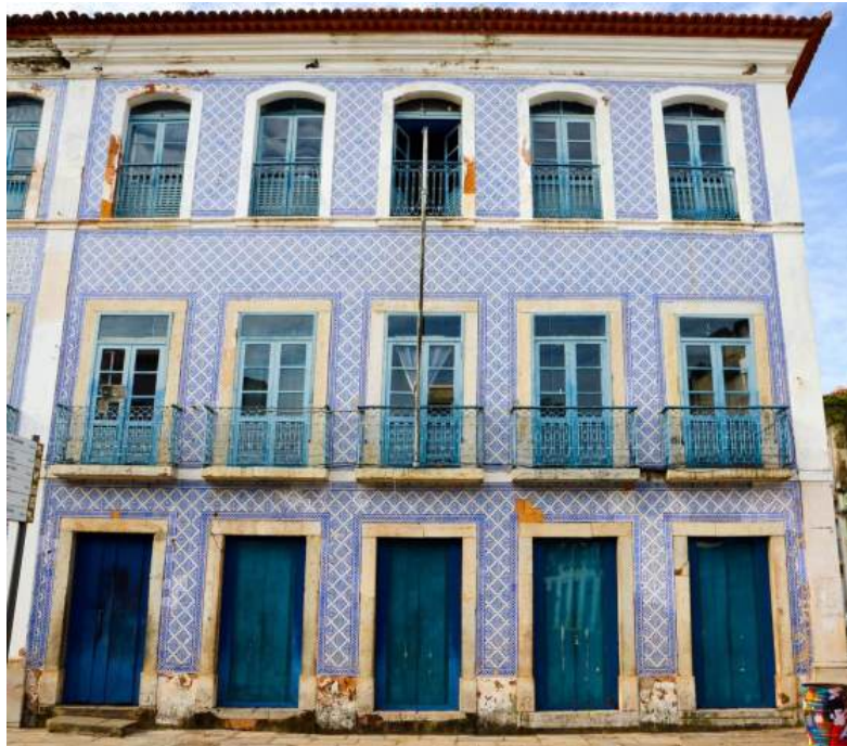
Figura 3: Sobrado como tipologia arquitetônica mista, comercial-residencial.
