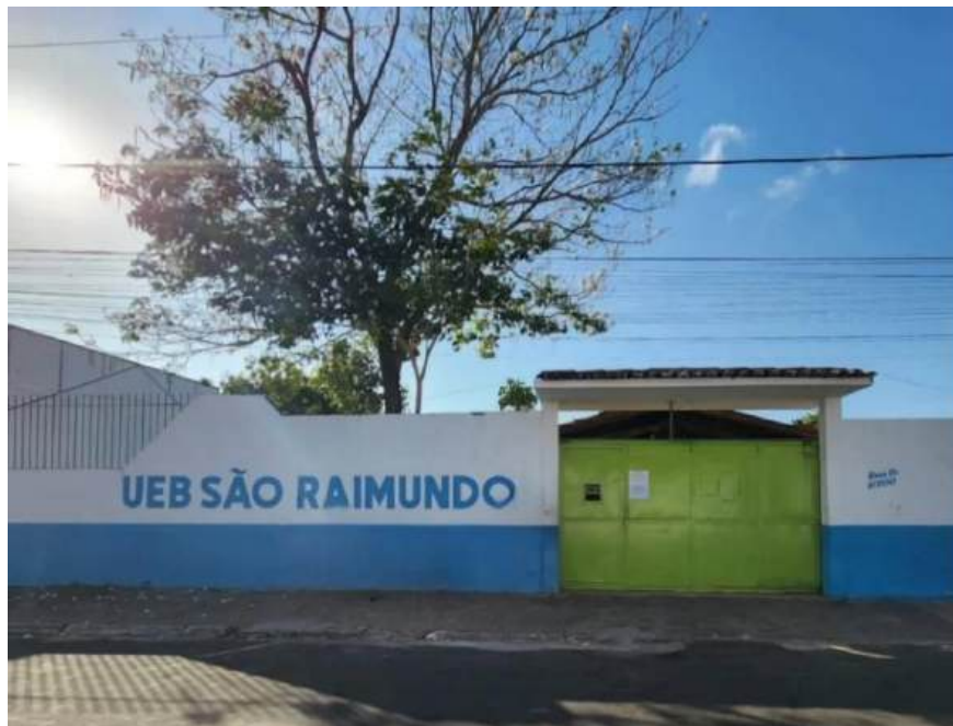
Figura 12: Fachada da UEB São Raimundo.
