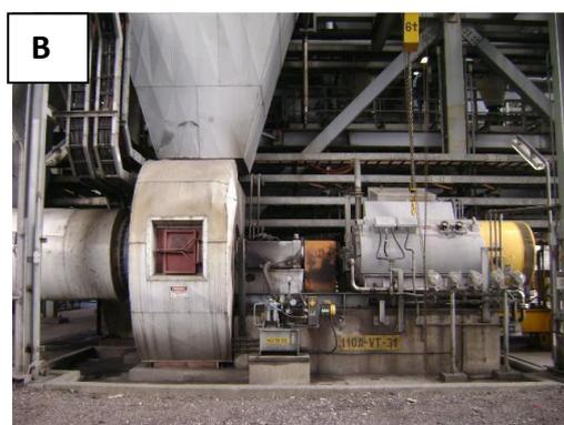
Figura 24 – Demonstração de Equipamentos do Sistema de Ar Primário. (A) Bocais localizados no interior das fornalhas das caldeiras e (B) Vista frontal do ventilador de ar primário de uma das caldeiras.
