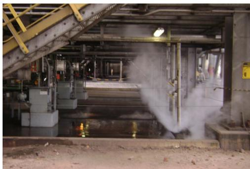
Figura 27 – Demonstração de Equipamento do Sistema de Alimentação de Água/Condensado (Bombas de Alimentação de Água à esquerda).
