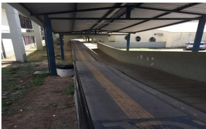
Figura 18 - Rampa da escola
