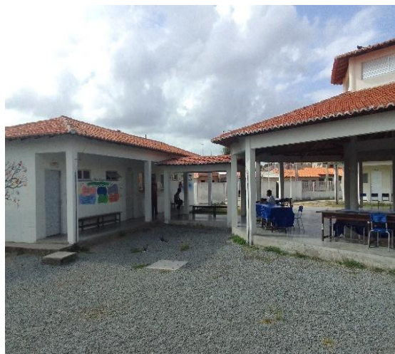
Figura 7- vista da sala de Direção e área de vivência Fonte: arquivo pessoal da autora
