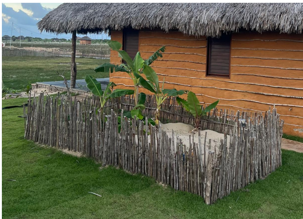
Figura 8 – TEVAP finalizado na Pousada Vila Ronquinha, com mudas plantadas e cercado de varinhas para proteção e delimitação da área.
