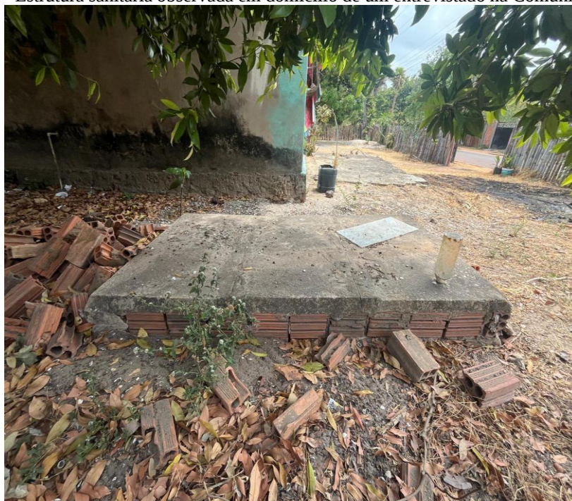
Figura 13 – Estrutura sanitária observada em domicílio de um entrevistado na Comunidade Mojó.
