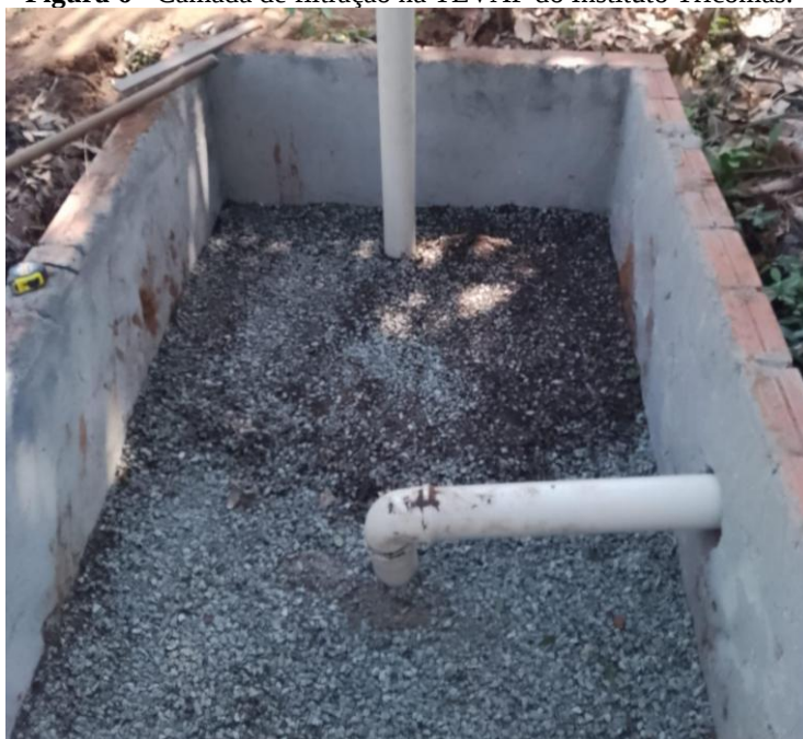
Figura 6 - Camada de filtração na TEVAP do Instituto Tricomas.
