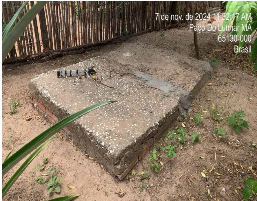
Figura 12 – Fossa séptica artesanal registrada em residência de entrevistado na Comunidade Mojó.
