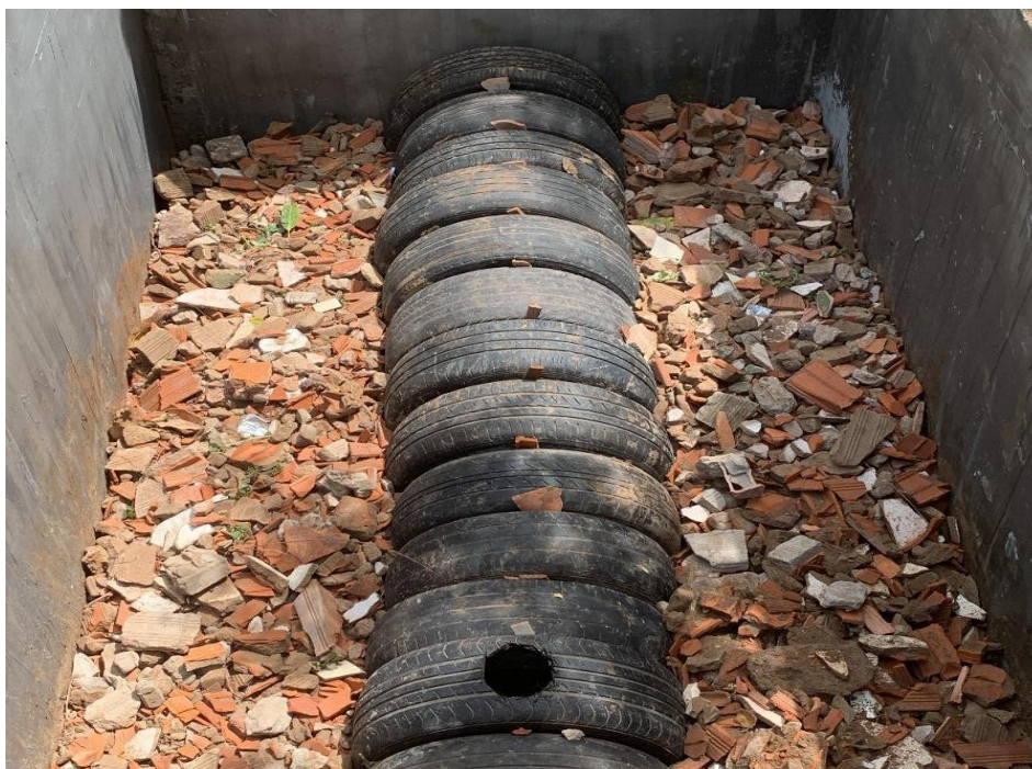
Figura 5 - Camada de suporte na TEVAP na da ONG Arte Mojó
