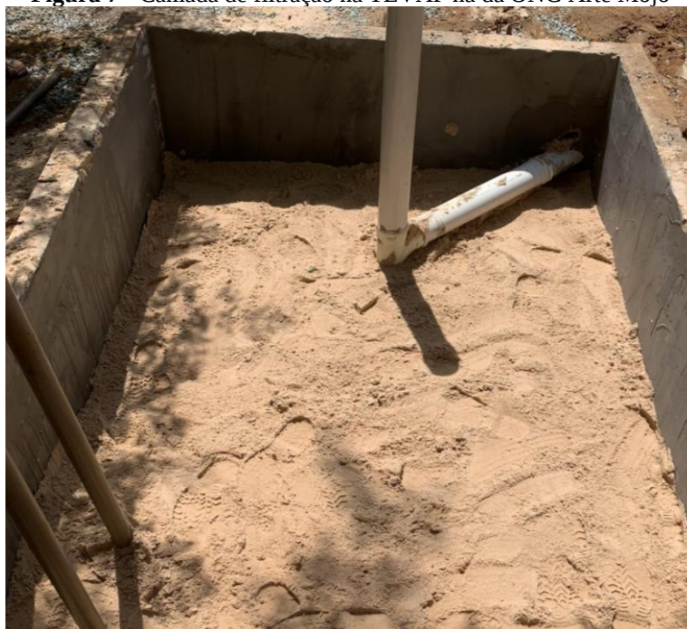
Figura 7 - Camada de filtração na TEVAP na da ONG Arte Mojó
