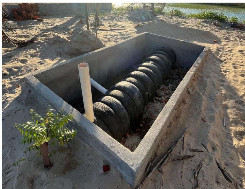
Figura 4 - Câmara anaeróbia construída com pneus reutilizados na TEVAP da Pousada Vila Ronquinha, São Luís (MA).
