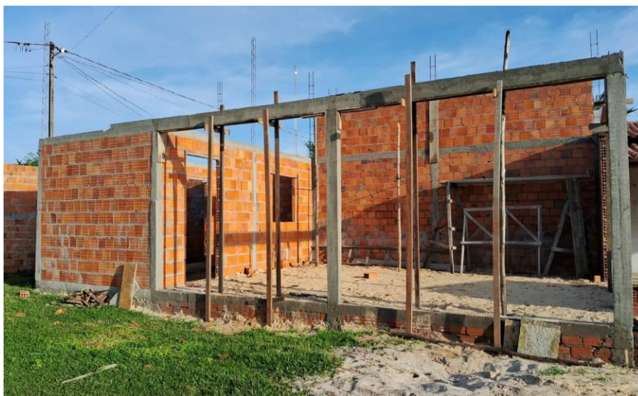
Figura 64 - Sede em construção
