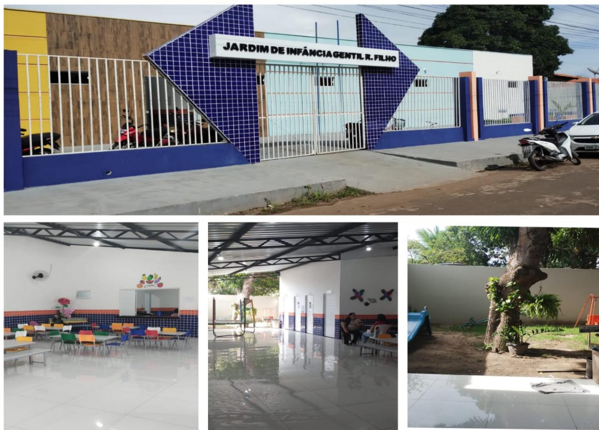
Figura 15 – Fachada e espaços internos Escola Municipal Gentil Rezende
