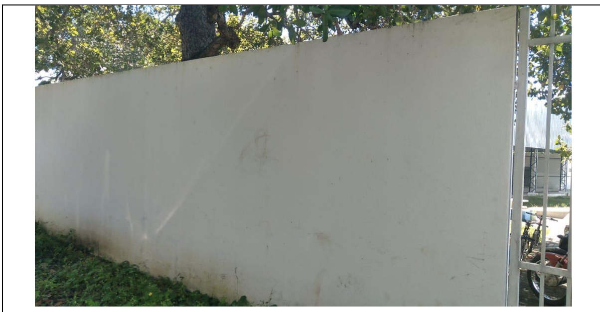
Muro da Escola, antes da pintura do mural.
