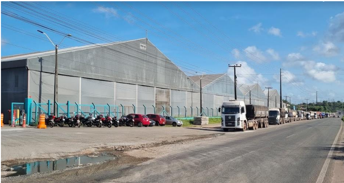
Figura 22 - Instalações de operadora portuária na BR-135
