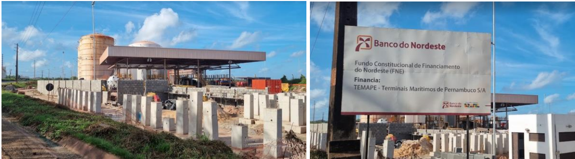
Figura 18 - Obra dos Terminais Marítimos de Pernambuco
