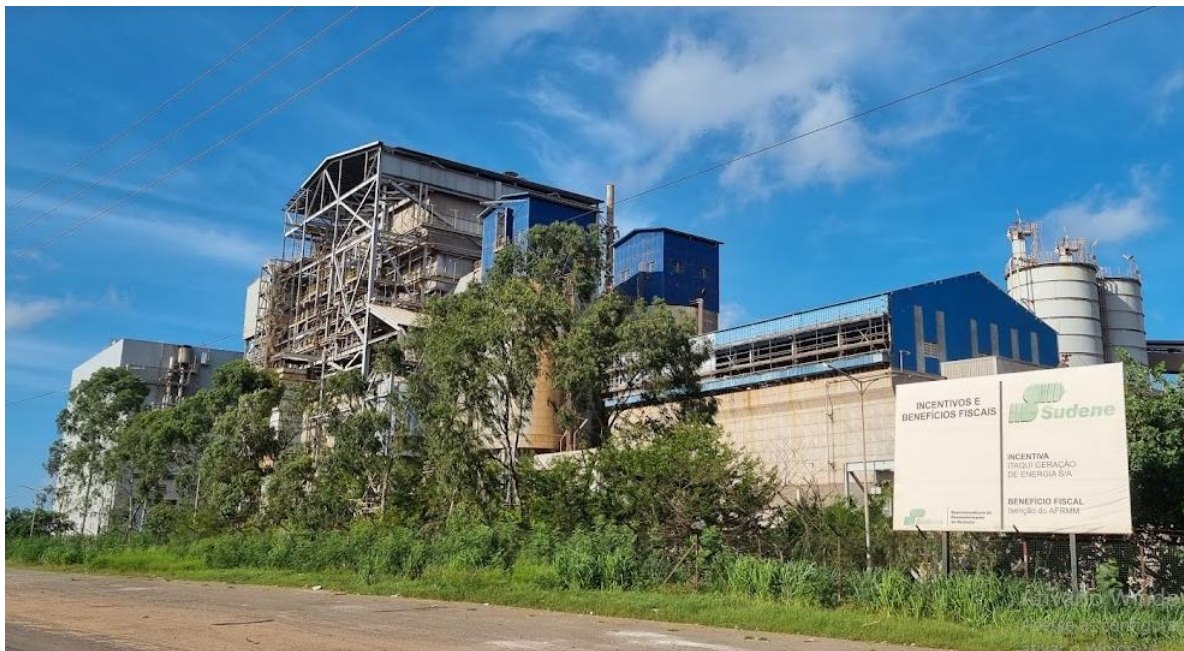
Figura 21- Usina termoeletrica da Eneva
