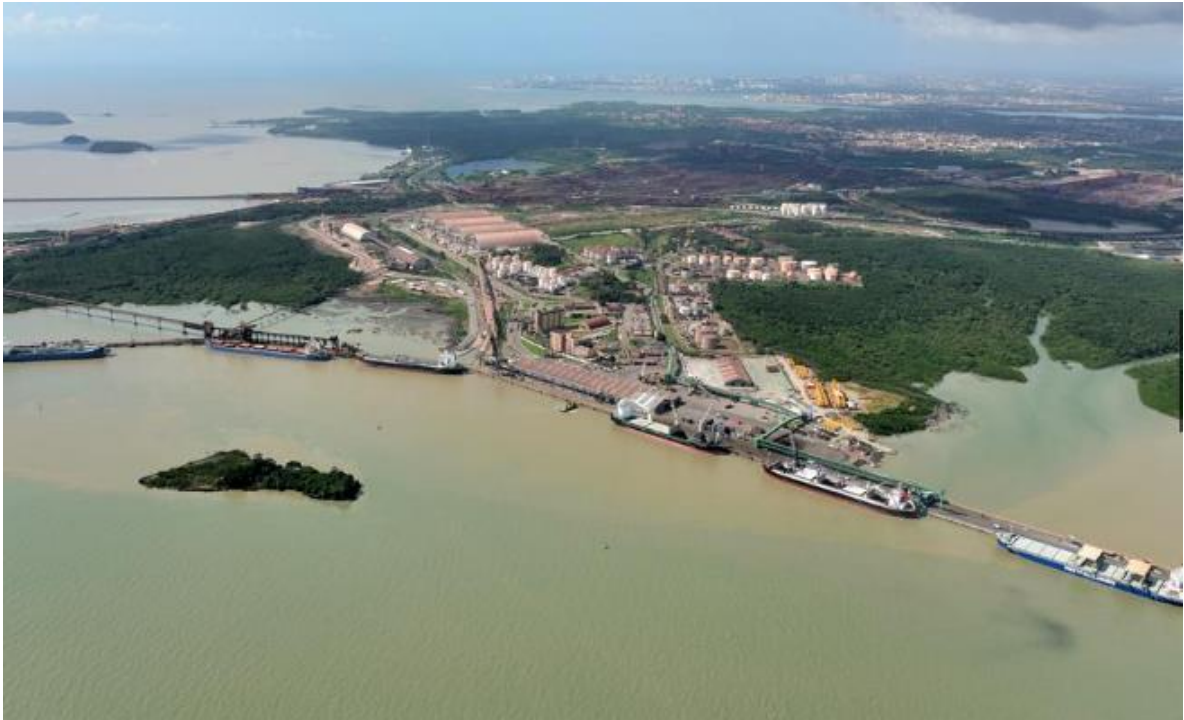
Figura 8 – Foto aérea das instalações atuais do Porto do Itaquí
