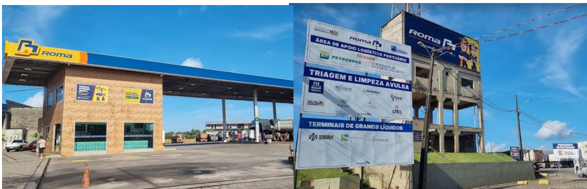
Figura 24 - Posto de combustíveis e pátio de estacionamento de carretas
