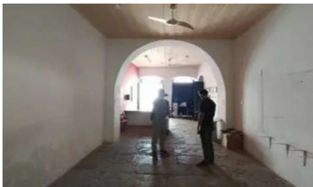
FIGURA 4 – Espaço interno do EQT Lab antes das reformas
