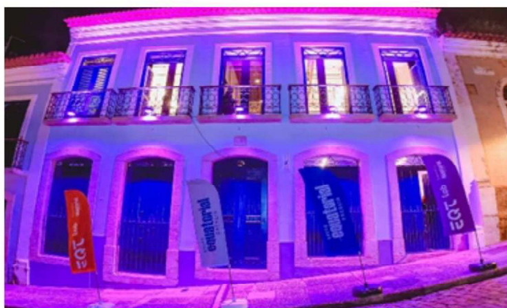
Figura 1 – Sede do EQT Lab em São Luís, MA
