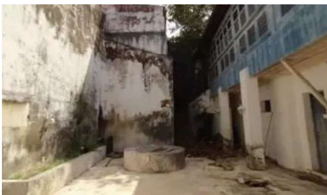
FIGURA 6 – Pátio interno do EQT Lab antes das reformas
