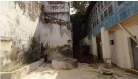
Figura 4 – Pátio interno do EQT Lab antes das reformas
