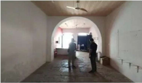
Figura 2 – Espaço interno do EQT Lab antes das reformas
