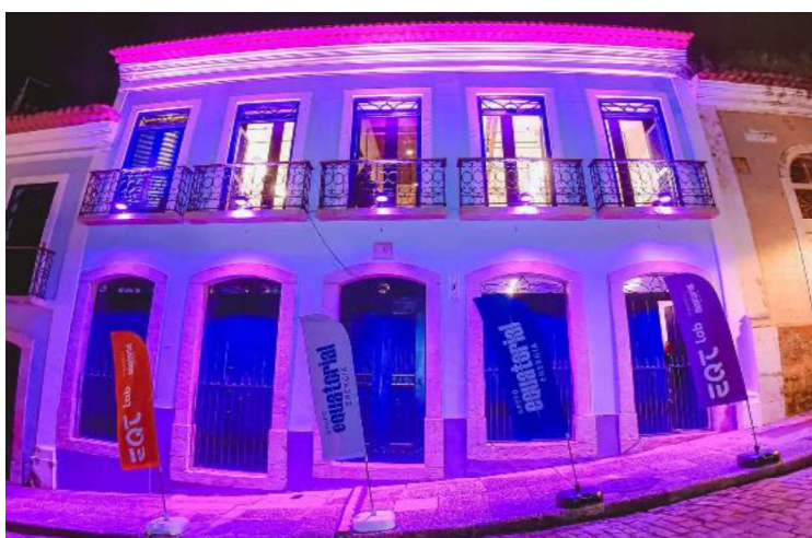
FIGURA 2 – Sede do EQT Lab em São Luís, MA
