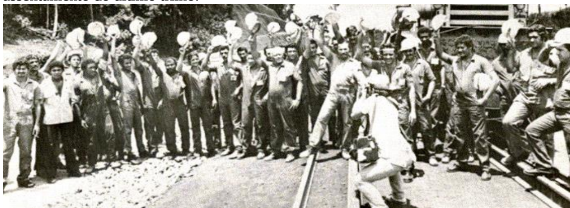
Figura 01: Trabalhadores da Estrada de Ferro Carajás posam para fotografia após o assentamento do último trilho.
