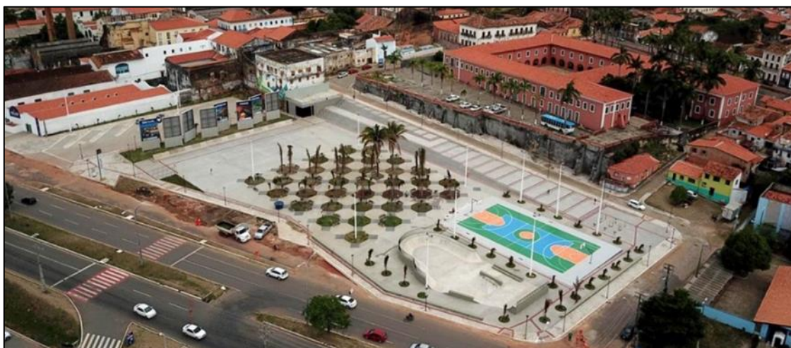
Figura 10 - Vista aérea da Praça das Mercês
