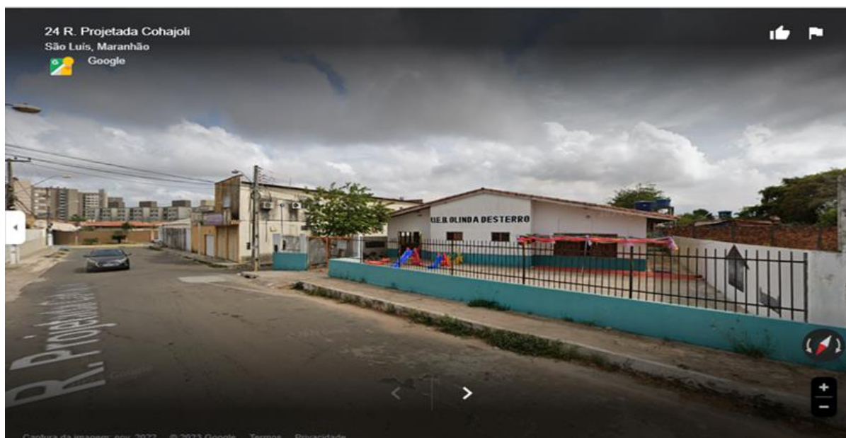
Foto 1 - Fachada da UEB Olinda Desterro antes da reforma
