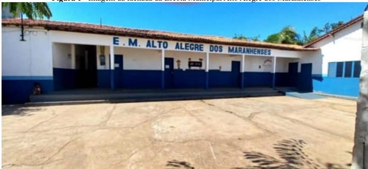
Figura 1 - Imagem da fachada da Escola Municipal Alto Alegre dos Maranhenses
