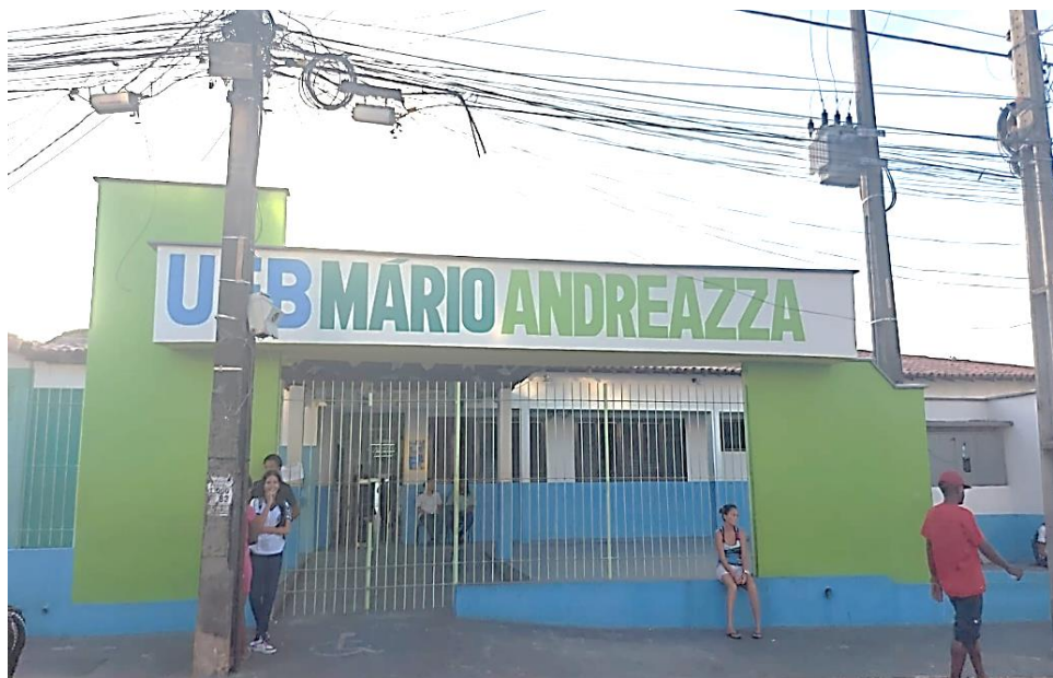
Figura 2 – Fachada da U.E.B Mário Andreazza
