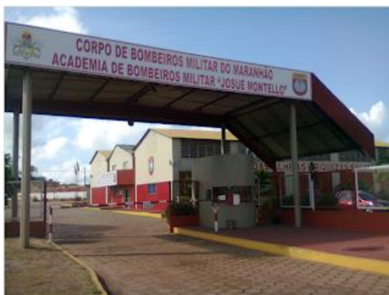
Figura 6 – Fachada da ABMJM
