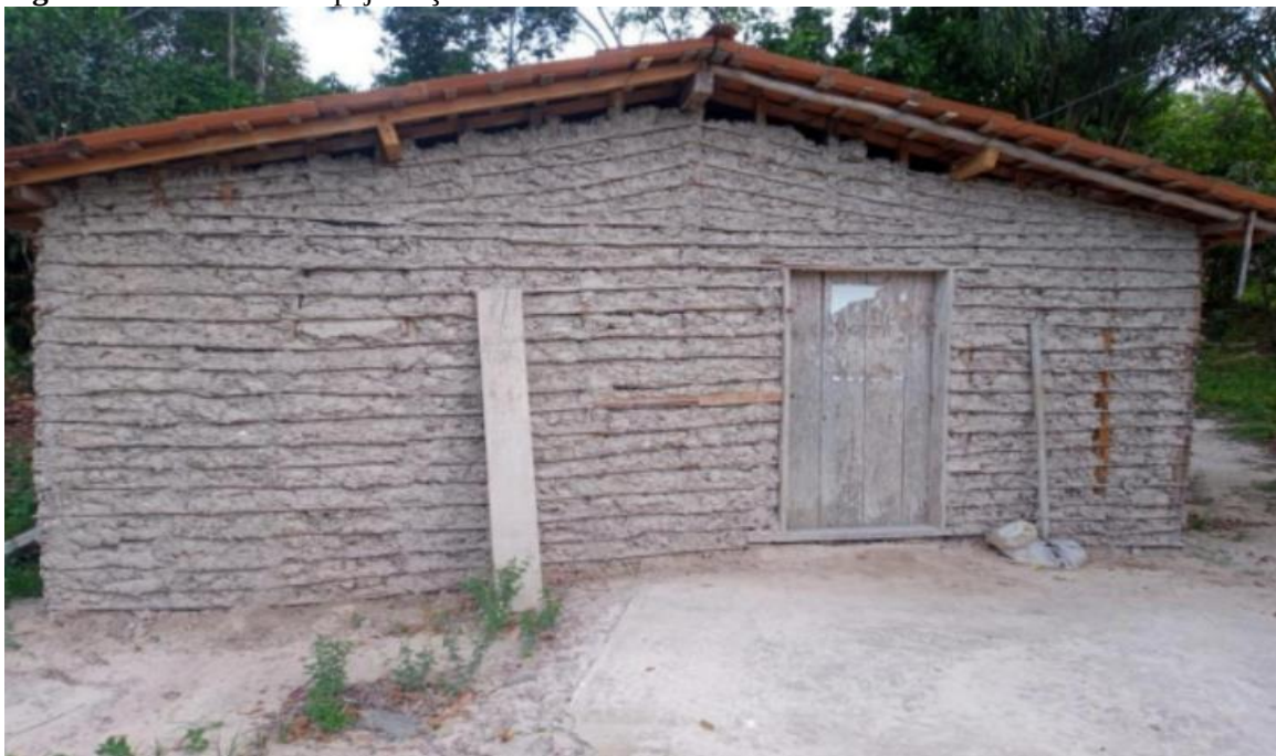
Figura 43 – Barracão de pajelança da comunidade de Imbiral
