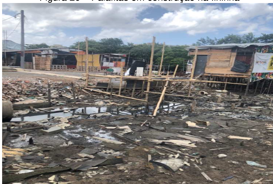
Figura 20 – Palafitas em construção na Ilhinha
