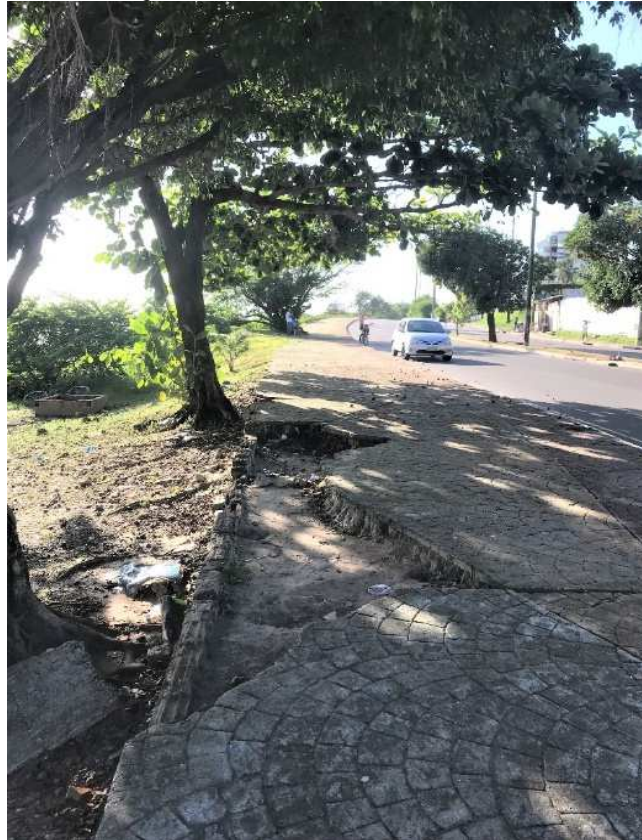
Figura 23 – Calçamento da Avenida Ferreira Gullar, 2022
