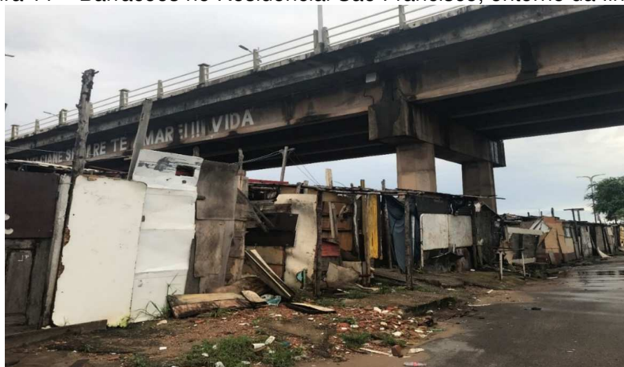
Figura 11 – Barracões no Residencial São Francisco, entorno da Ilhinha.
