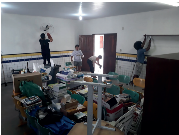
Figura 11: Execução da pintura e reforma do novo espaço de leitura da Escola Azul, a Biblioteca.
