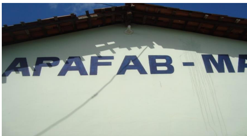
Figura 19 – Fachada da Associação (APAFAB), comunidade de São Cristóvão, Bacabeira-MA
