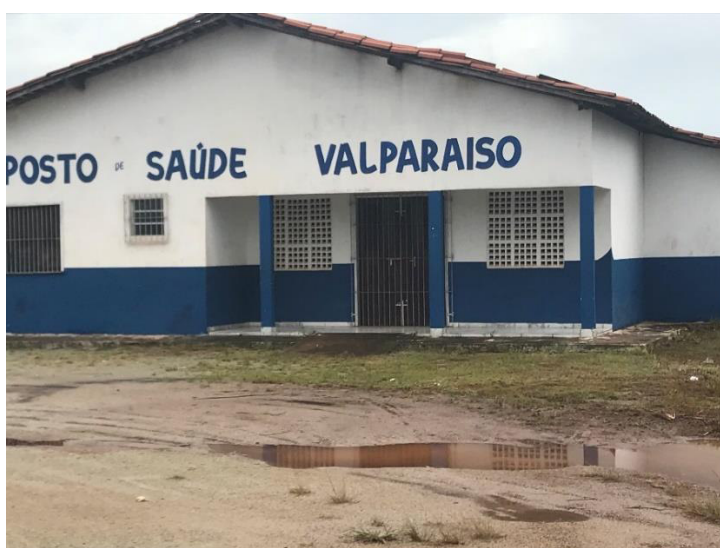
Figura 39 – Posto de Saúde de Salva Terra II (Valparaíso) sem funcionamento
