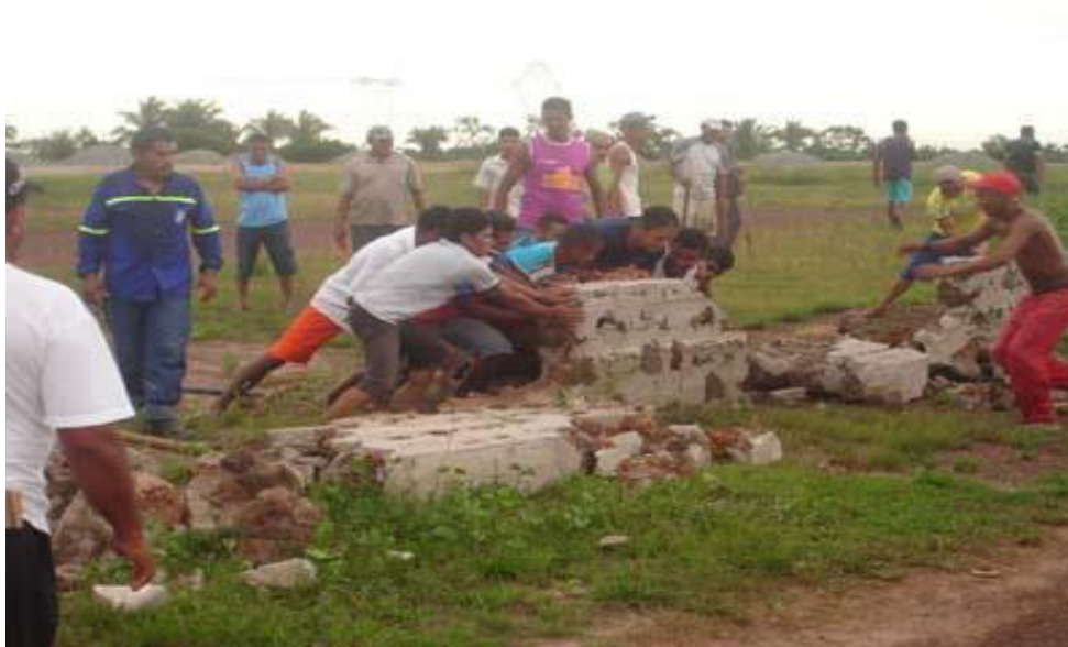
Figura 18 – Derrubada do Muro de Bacabeira
