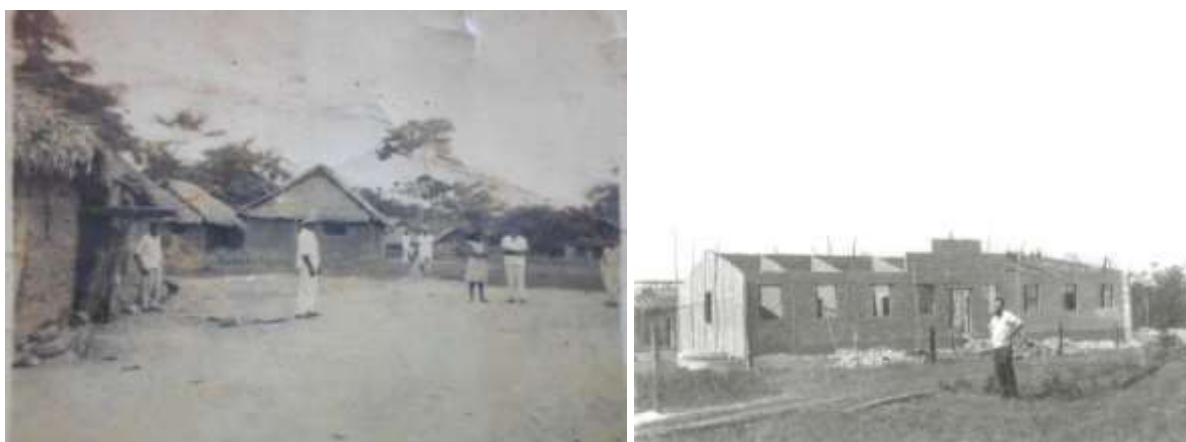
Figura 17 - O Povoado Lagoa Verde (1959-1960) no município de Imperatriz e a construção da Igreja Nossa Senhora de Nazaré, onde funcionou a escola paroquial dirigida na época por Frei Osvaldo que aparece na imagem vistoriando a obra.
