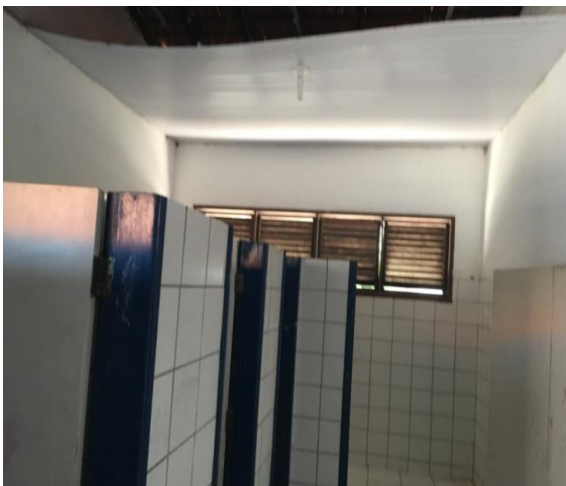
FOTO 9: Infraestrutura da Escola Municipal Zilda Maria Santos Mesquita
