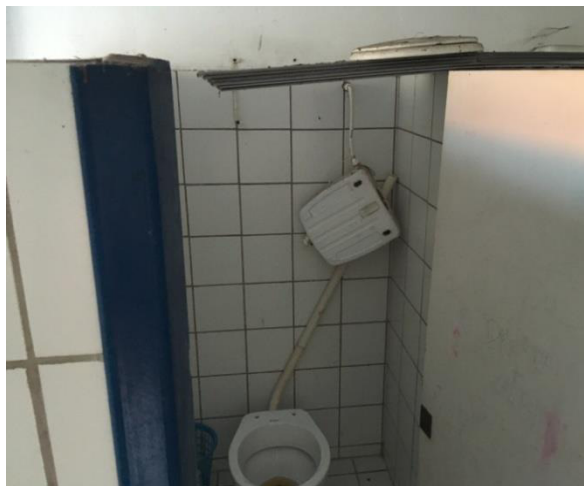
FOTO 10: Infraestrutura da Escola Municipal Zilda Maria Santos Mesquita
