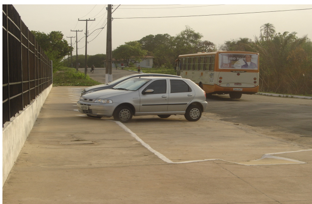
FIGURA 5 – Inadequação da vaga de estacionamento para pessoas com deficiência no COLUN em 2006
