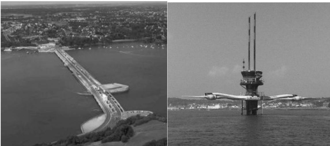
**Figura 2.5. Exemplos de aproveitamentos da energia das marés. (a) Energia potencial. (b) Energia cinética.**
