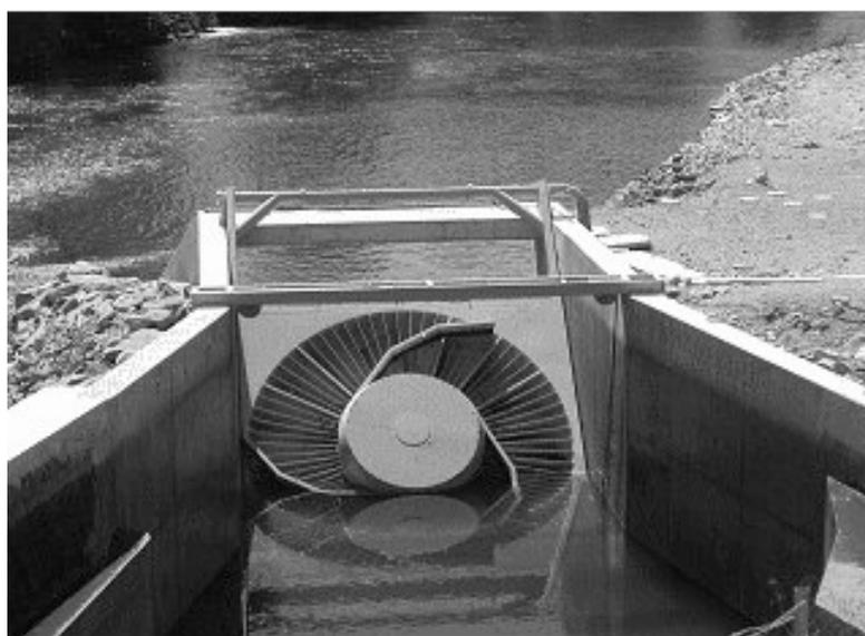
Figura 2.12. Vista do modelo de turbina *VLH* instalado em Milau, França [28].
