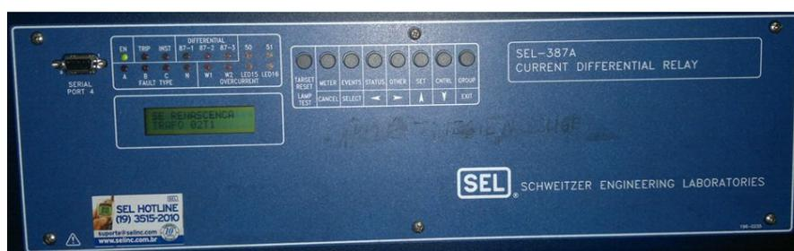
Figura 2.7: Relé SEL 387-A para proteção do Transformador 1 da Subestação Renascença (CEMAR).
