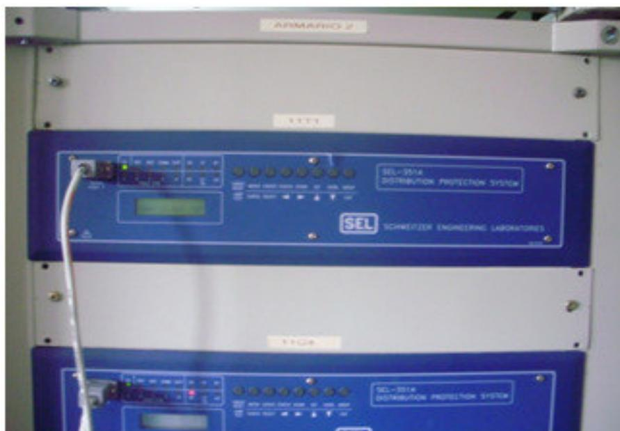
Figura 2.6: Relé SEL 351-A em operação na subestação São Francisco (CEMAR).
