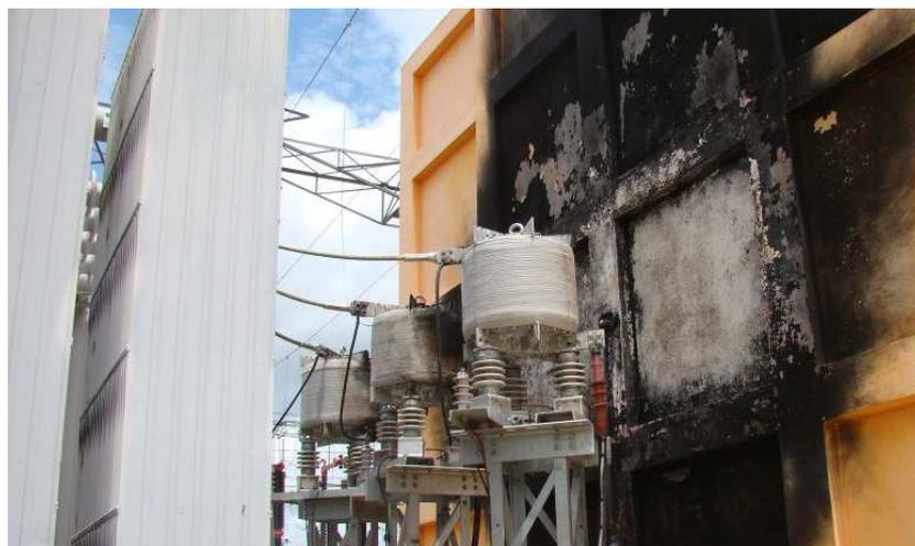
Figura 6.13 – Foto dos reatores limitadores avariados após curto-circuito na SEMR em que houve falha de um IED [78]
