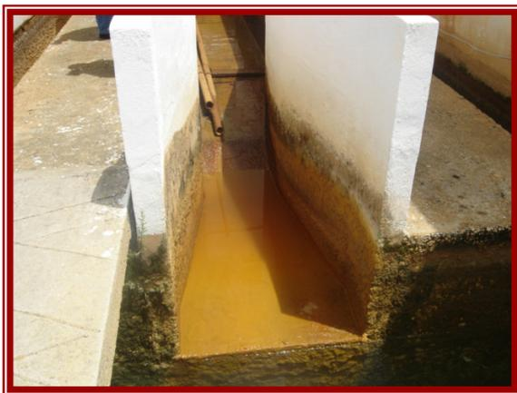
Entrada de água pós mistura química para fase de floculação na Calha Parshall sem utilização de difusor para espalhar o produto e melhorar a floculação.
