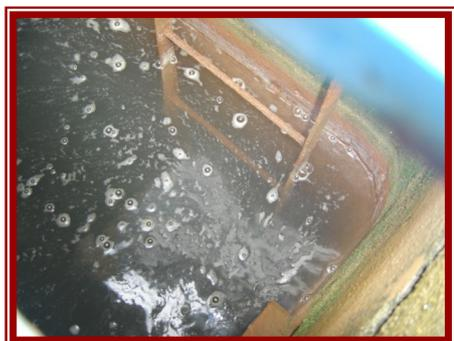
Tanque de água tratada – escada de ferro oxidada
