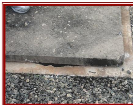
Tampa do reservatório de água tratada com pequena abertura, favorecendo entrada de sujeira, água pluvial ou vetores.
