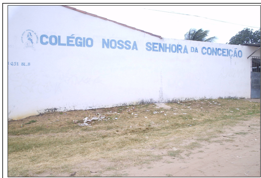
Figura 48: A escola, no canto o portão, a entrada principal
