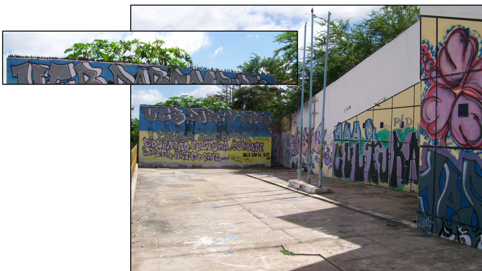
FIGURA 50: Muros, no detalhe os grampos. Uma muralha para o templo.
