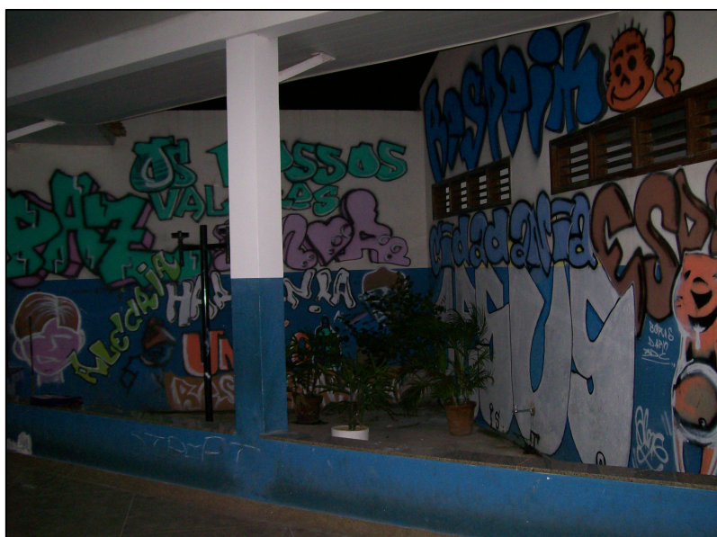
FIGURA 60: Abertura para o alto, espaço de vazão.
