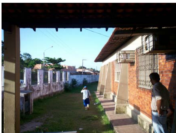
O fosso (vão entre o muro da escola e a estrutura interior da mesma)
