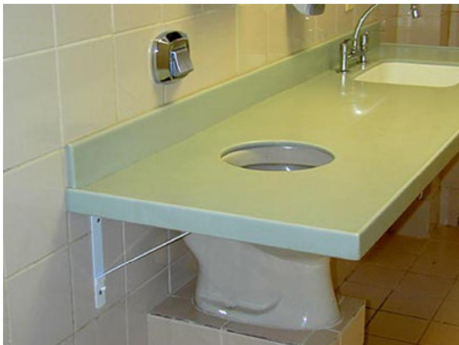
Figura 30: Sala de Utilidades: pia de expurgo integrada à bancada
